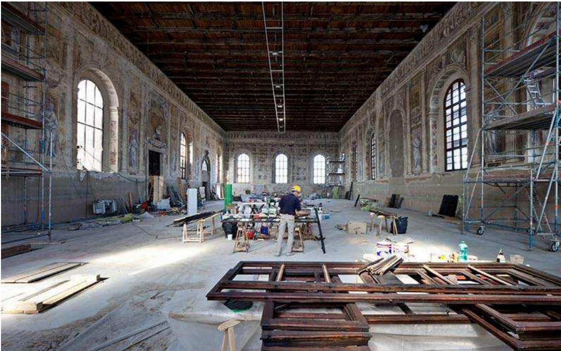
Figure 15 - The Scuola Grande della Misericordia during restorations
