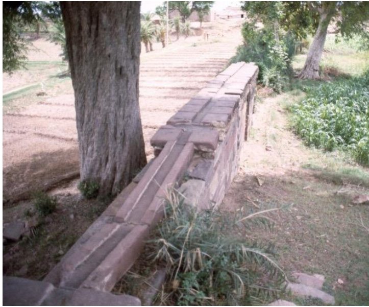
Figura 18: condotta idraulica sopra il muro del Bagh-i Nilufar, Dolphur, Rajasthan.
