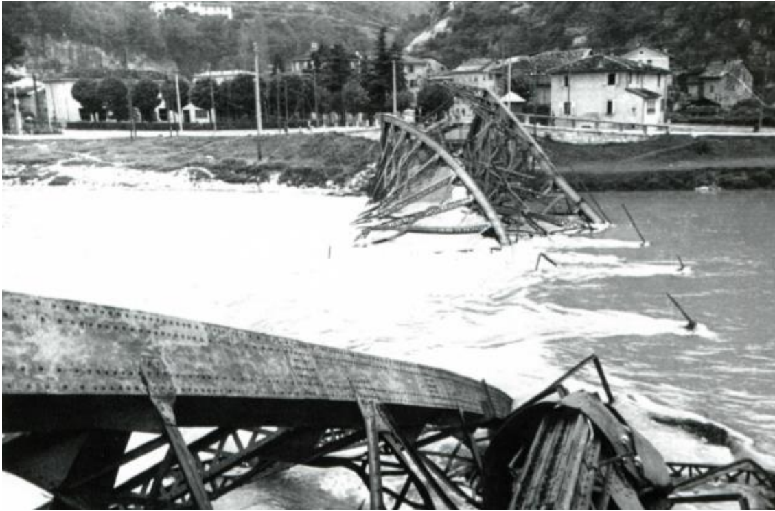
Fig. 11 Ponte di San Lorenzo. 2 settembre 1943, Mariz 2012, pag. 107
