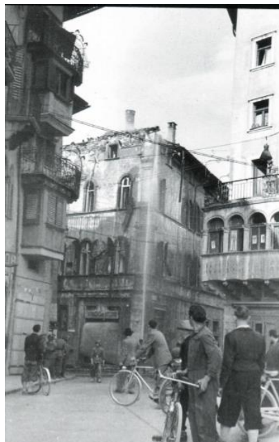
Fig. 35 Incendio di Palazzo Dal Monte. 13 maggio 1944, Leoni, Marchesoni 1995, pag. 92
