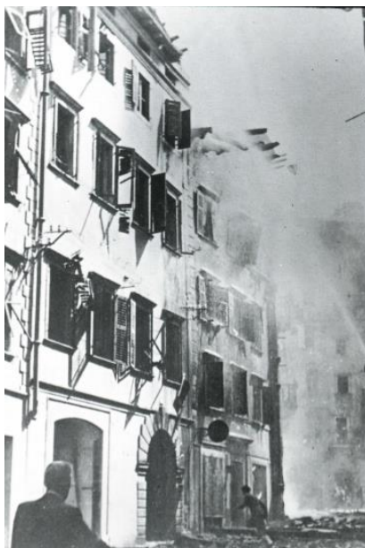
Fig. 34 Incendio di Palazzo Dal Monte. 13 maggio 1944, Leoni, Marchesoni 1995, pag. 92
