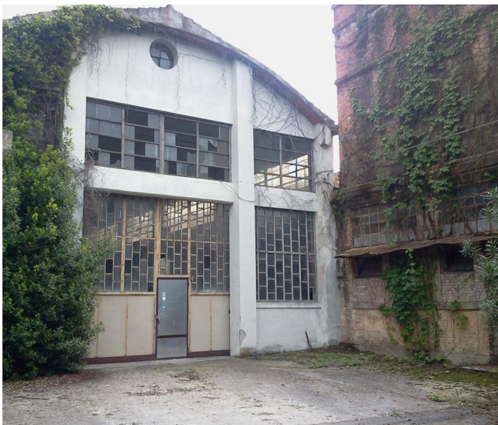
Ex officine. Particolare dell'esterno. Foto scattata nel maggio 2014, Roncade.
