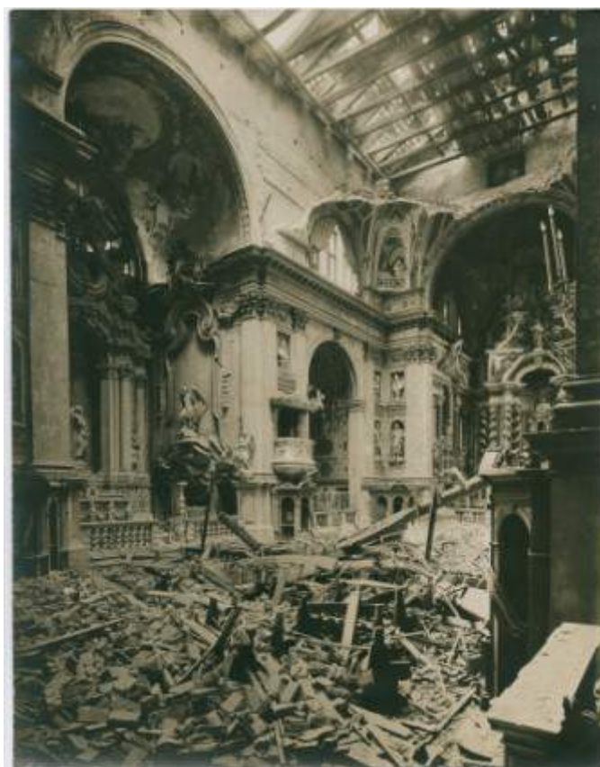
Figura 10: Il crollo del tetto della chiesa degli Scalzi
