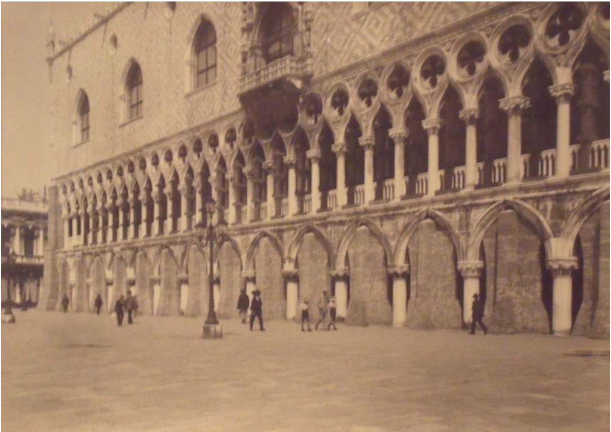
Figura 8: Palazzo Ducale con i puntellamenti degli archi
