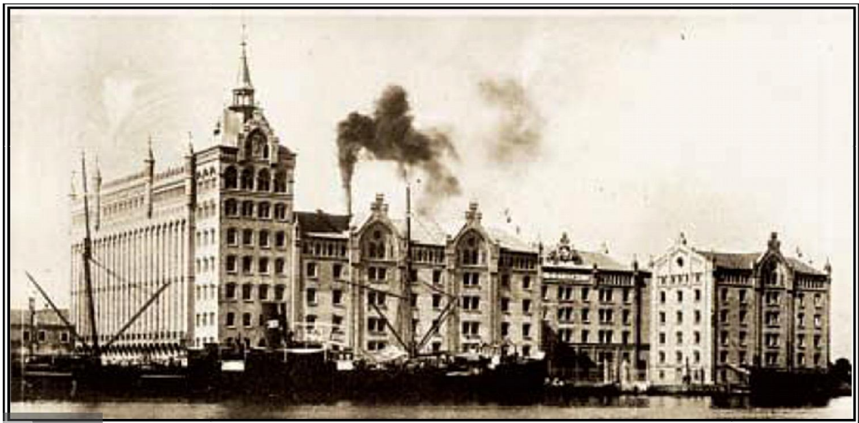
Figura 3.1 Facciata dell'Hilton Molino Stucky Venice.
