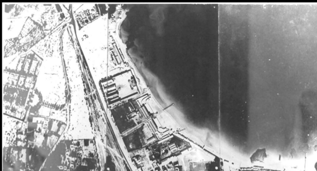
Tripoli 1940, Lido Nuovo, veduta aerea
