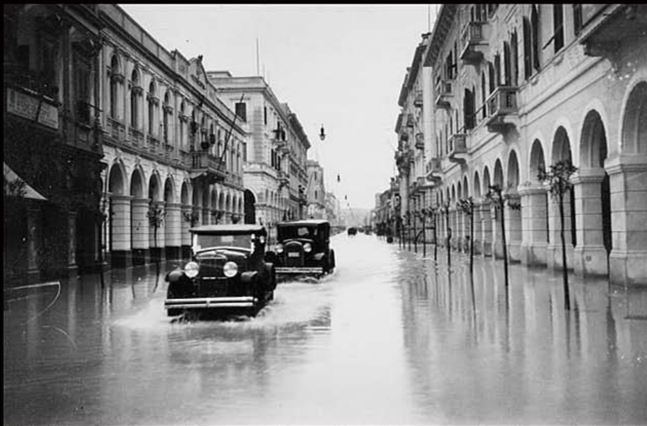
1933, L'Uadi prima delle opere di canalizzazione esonda allagando la città per cortesia di P. Cason
