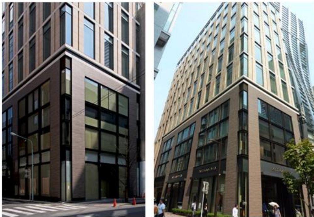
Figura 34: Negozio Bottega Veneta di Ginza prima e dopo i lavori, 2007.
