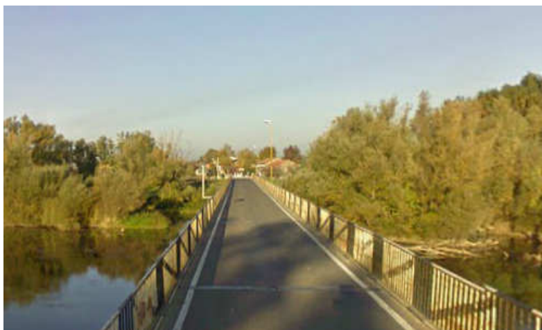
Figura 51 Ponte di Carturo fonte: foto dell'autore
