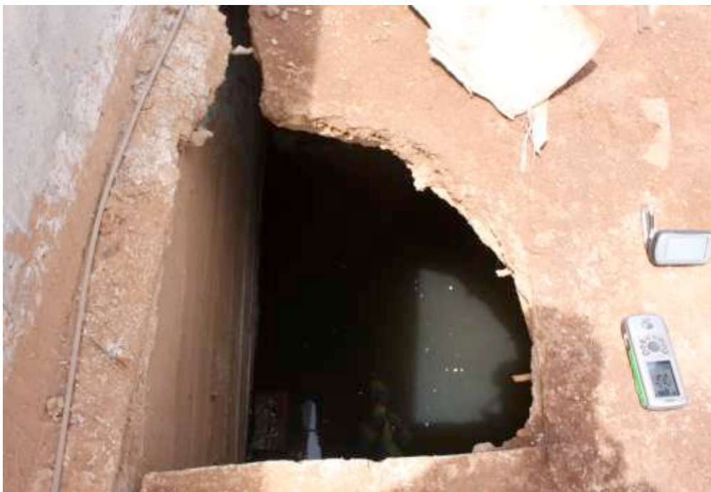
Figura 65. Pozzo settico della centrale elettrica (Foto di Tringali, agosto 2012).
