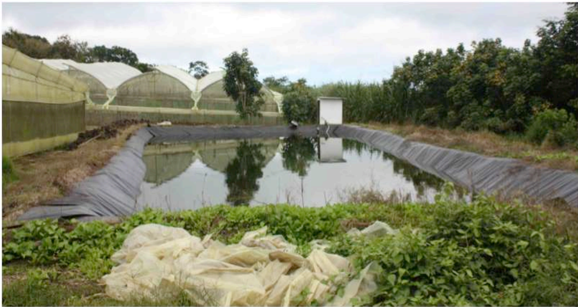
Figura 23. Foto delle geomembrana nella zona agricola dell'isola di Santa Cruz. (Foto di Tringali, agosto 2012).
