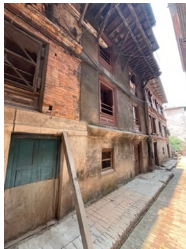
Figure 3.1/3.2/3.3/3.4- Sostegni di legno per evitare la caduta delle case tradizionali in caso di nuove scosse di terremoto
