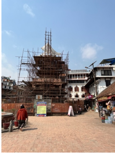
Figura 3.11- tempio in fase di restauro dopo al terremoto del 2015 (Foto di Marianna Cerrina 2024)
