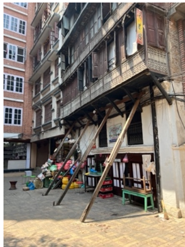
Figure 3.1/3.2/3.3/3.4- Sostegni di legno per evitare la caduta delle case tradizionali in caso di nuove scosse di terremoto
