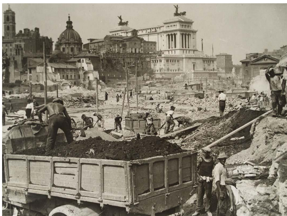
Fig. 1: Veduta dell'area dei Fori Imperiali durante i lavori di demolizione e costruzione, 23 settembre 1932
