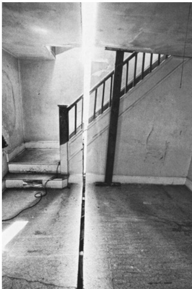
Fig. 88 Gordon Matta-Clark, Particolare della fenditura creatasi nell'abitazione durante Splitting , 1974, New Jersey.
