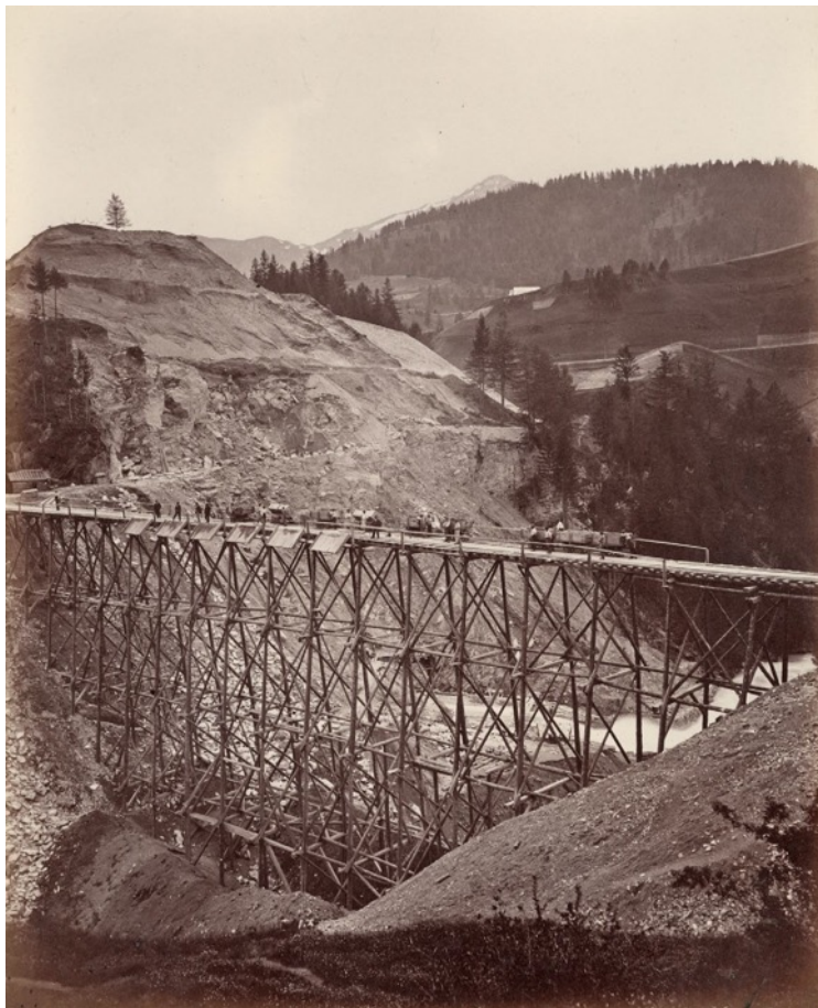
Figura 13. Carl Alexander Czichna, Impalcatura per la costruzione della ferrovia presso il Schlossberg di Matri al Brennero , giugno 1866, Collezione C. A. Czichna – TAP, CC BY 4.0, https://elearning.lichtbild-argentovivo.eu/ilias.php?ref_id=220&obj_id=291&obj_type=StructureObject&cmd=layout&cmdClass=illmpresentationgui&cmdNode=di&baseClass=ilLMPresentationGUI
