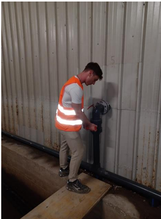
Figura 9. Fase di regolazione del flusso d'aria nel retro di una biopila
