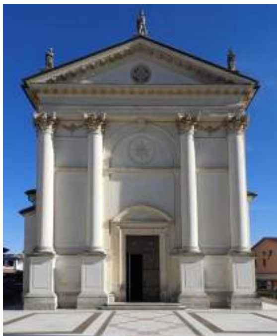
Fig.10. Mussolente, Chiesa dei SS. Pietro e Paolo , facciata.
