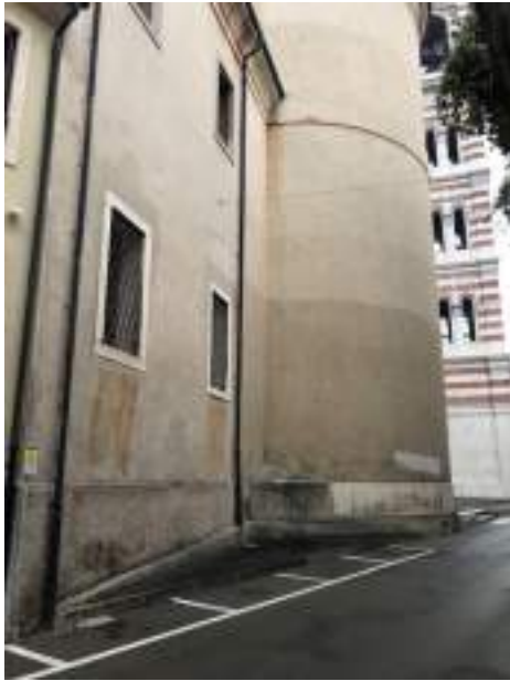
Fig. 25. Arzignano, Duomo di Ognissanti , Prospettiva del transetto dalla parte di Via Camillo Cavour .
