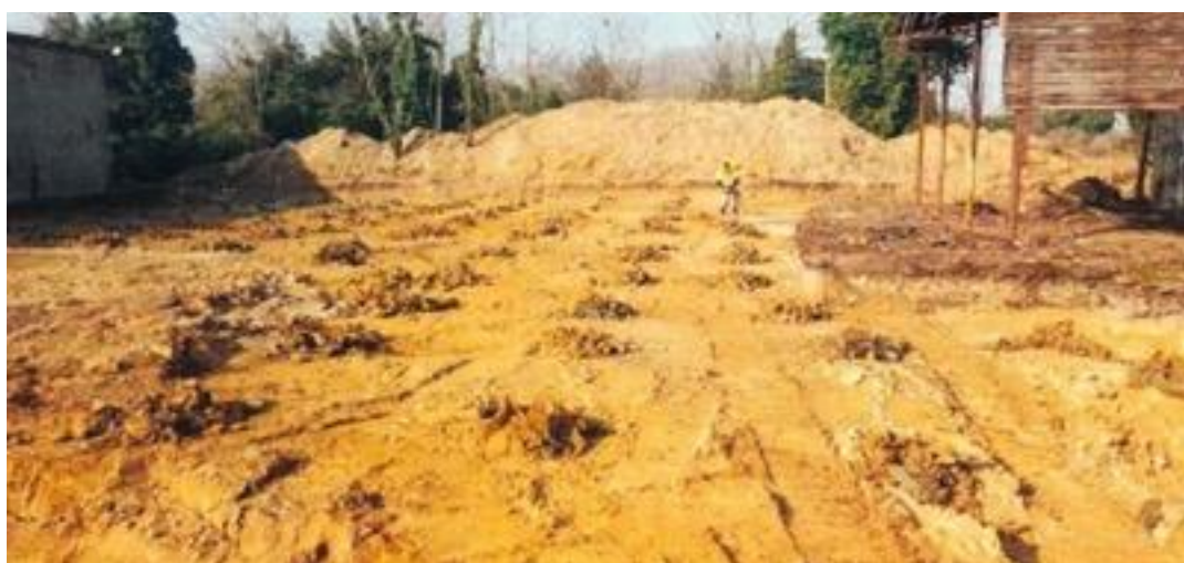
Figura 4.4 - sbancamento e trivellazioni nell'area tra i 2 edifici.
