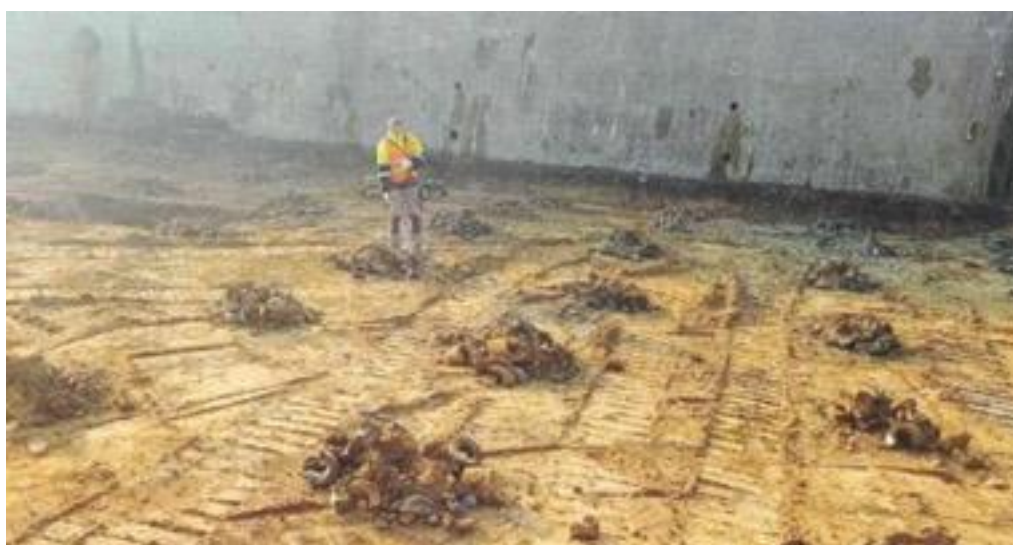
Figura 4.3 - sbancamento e trivellazioni al lato N dell'edificio A
