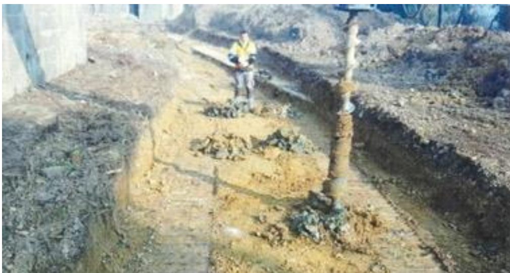
Figura 4.2 - sbancamento e trivellazioni al lato E dell'edificio A
