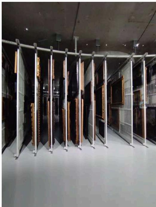
Fig. 102: MVRDV, *Depot Boijmans Van Beuningen*, 2021, Rotterdam. Il deposito più grande dell'edificio destinato ai dipinti. Si nota la presenza dei diversi racks distanziati e appoggiati sui binari di movimentazione. Fotografia di: Annachiara Pelosato, 2023.
