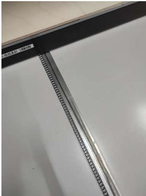
Fig. 119: MVRDV, *Depot Boijmans Van Beuningen*, 2021, Rotterdam. Dettaglio dei binari di scorrimento dei racks impiegati nelle stanze di deposito del Depot. Fotografia di: Annachiara Pelosato, 2023.
