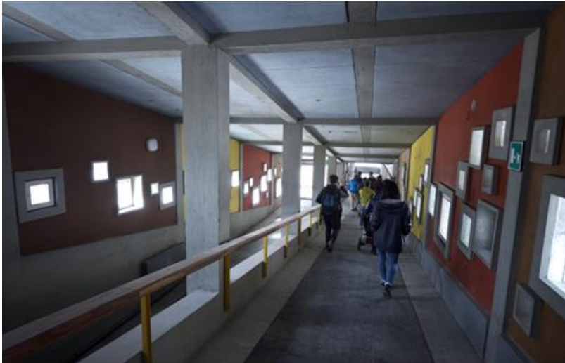
Figura 10 - I corridoi interni della colonia. Foto di Giacomo De Donà.
