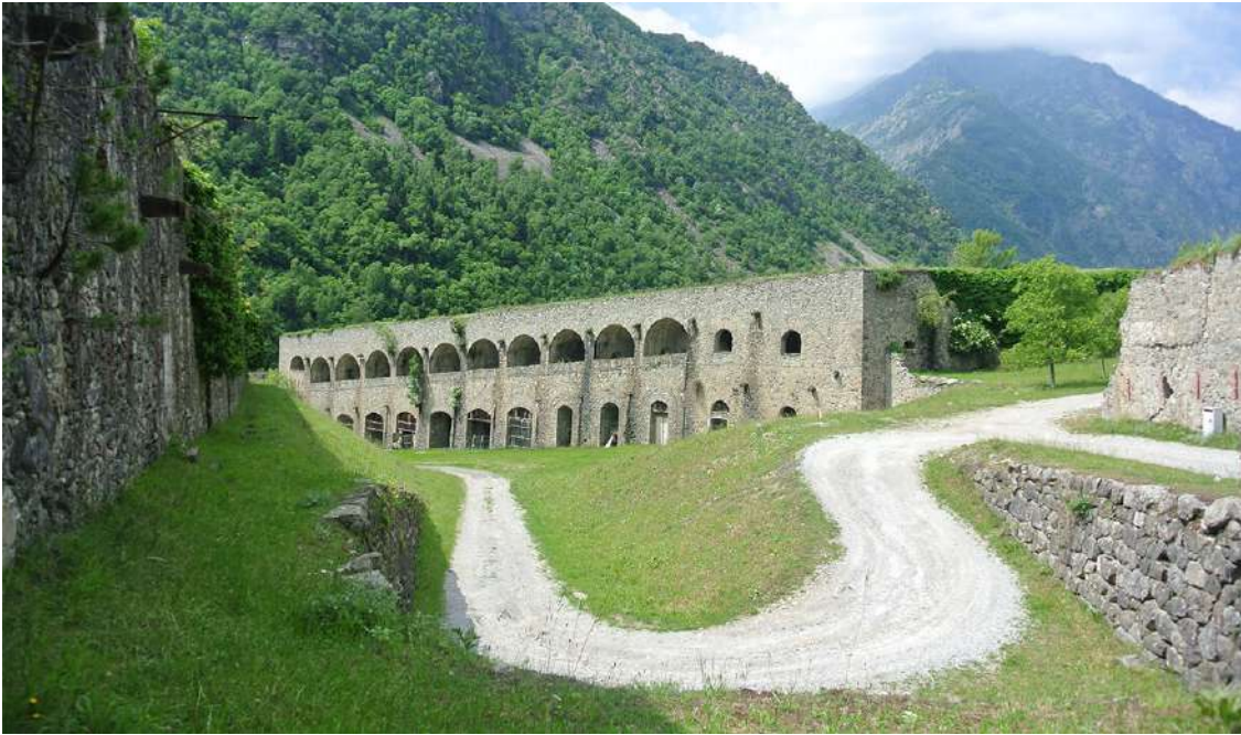
Fig. 17. Il Fronte Inferiore del Forte di Vinadio. Fonte: https://www.fortedivinadio.com/
