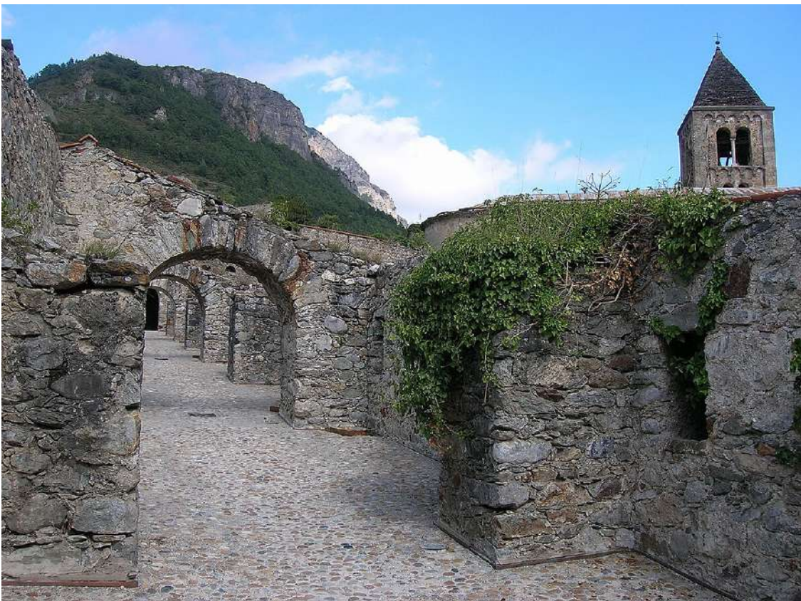
Fig. 18. Dettaglio architettonico del Fronte Superiore del Forte di Vinadio. Fonte: https://www.fortedivinadio.com/
