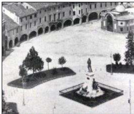
Figura 14 Piazza Mazzini in una foto del 1927 con la statua di Mazzini in primo piano e la Casa del Mutilato sullo sfondo (foto archivio Casa del Mutilato)
