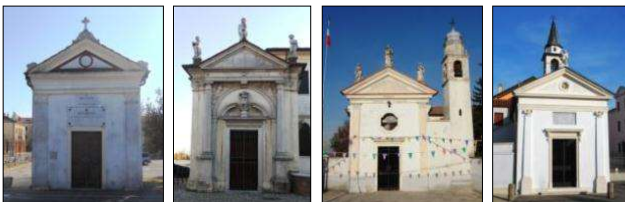
Figure 13-16 le cappelle-monumento ai caduti di Villanova di Camposampiero, Massanzago, Pionca di Vigonza, Camin di Padova
