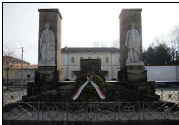
Figura 22 Paolo Boldrin. Il Monumento ai caduti di Ponte di Brenta, Padova
