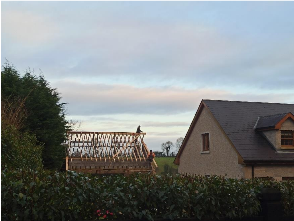
Fig. 10. Costruzione di un edificio nei dintorni della casa dei Reilly, 27/01/2023.
