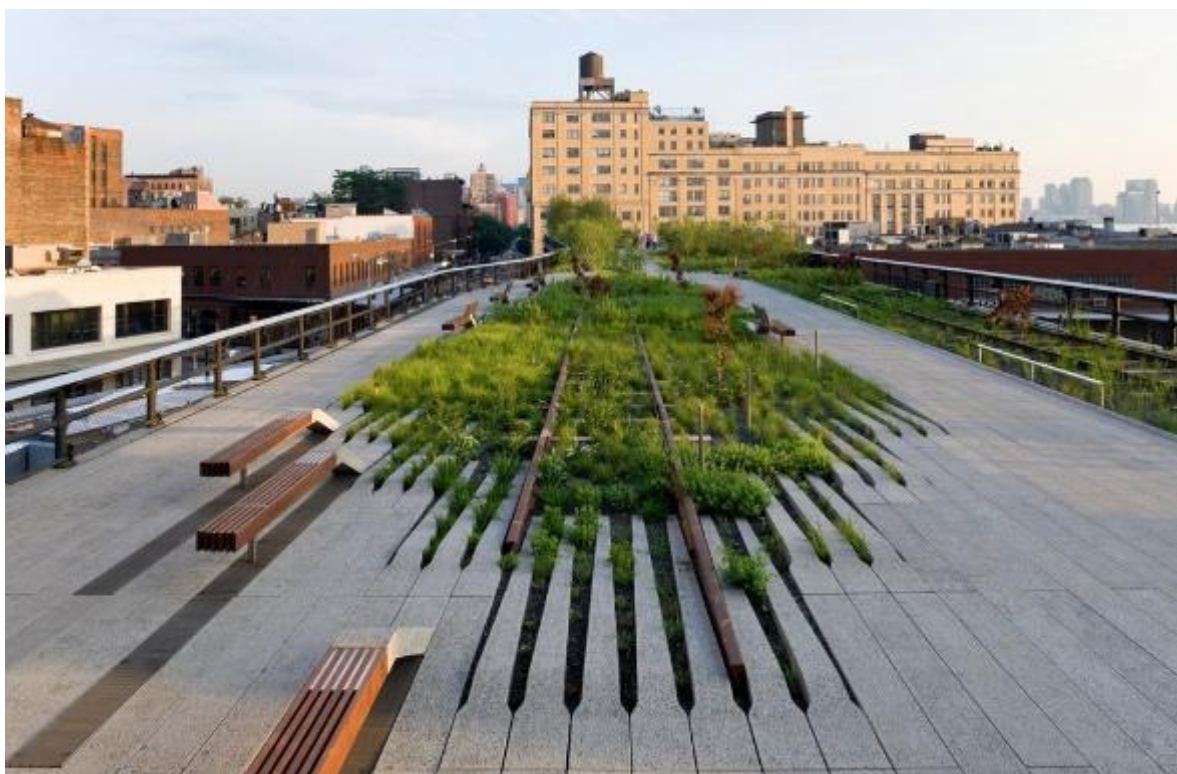
Fig. 81 Pavimentazione di High Line in cui si intersecano il verde, il cemento nuovo e l'antico binario , fotografia, 2014.
