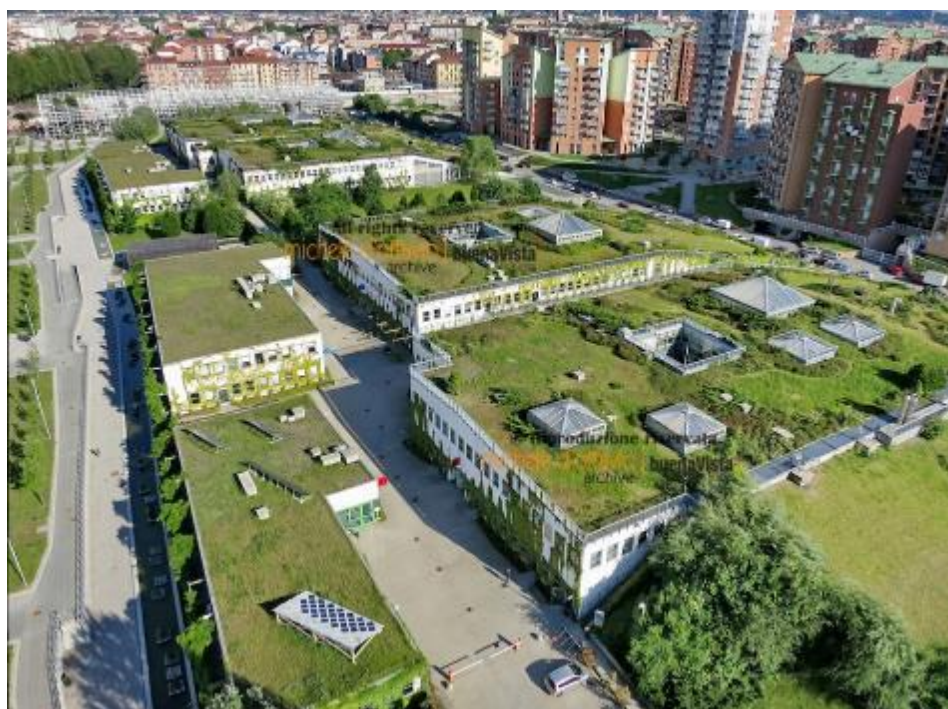
Fig. 74 Emilio Ambasz, Edifici dell'Environment Park, Torino , fotografia aerea, 2006.
