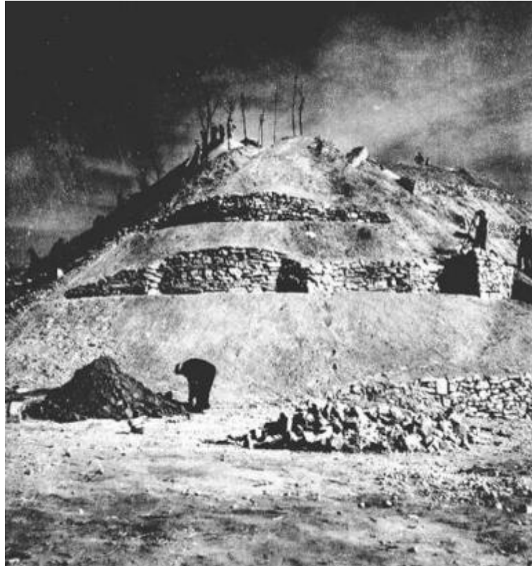
Fig. 59 Monte Stella in costruzione , fotografia d'epoca, archivio Bottoni.
