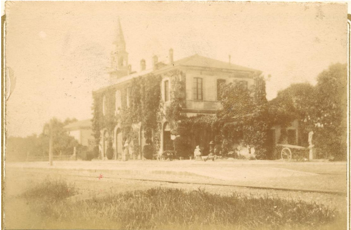
Figura 20. La stazione ferroviaria costruita nel 1877.
