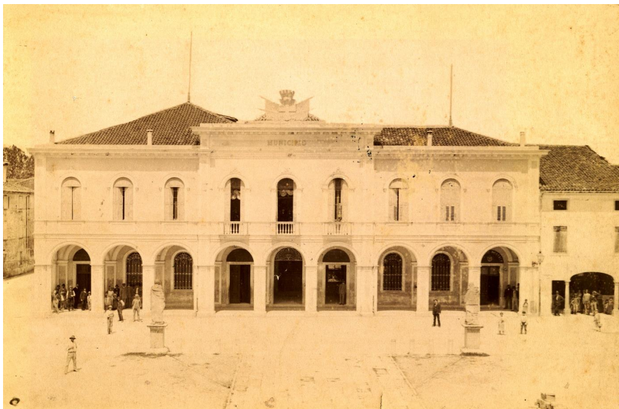
Figura 14. Facciata del palazzo municipale.
