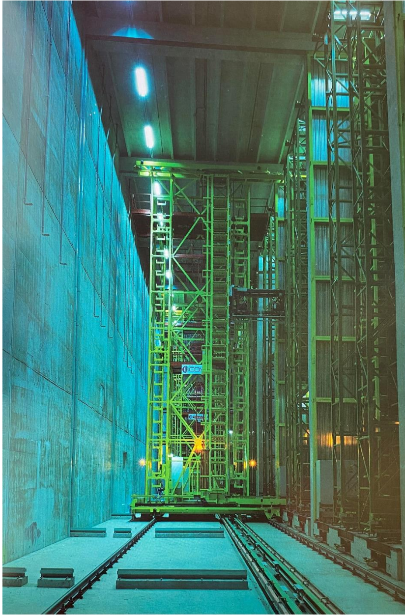
Fig. 40 - Afra e Tobia Scarpa, Magazzino robotizzato, Castrette di Villorba, 1980 (Benetton Group).
