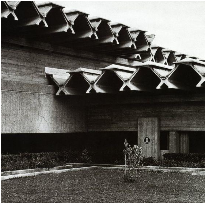
Fig. 14 - Afra e Tobia Scarpa, Fabbrica Benetton (dettaglio travi a X), Paderno di Ponzano, 1966.
