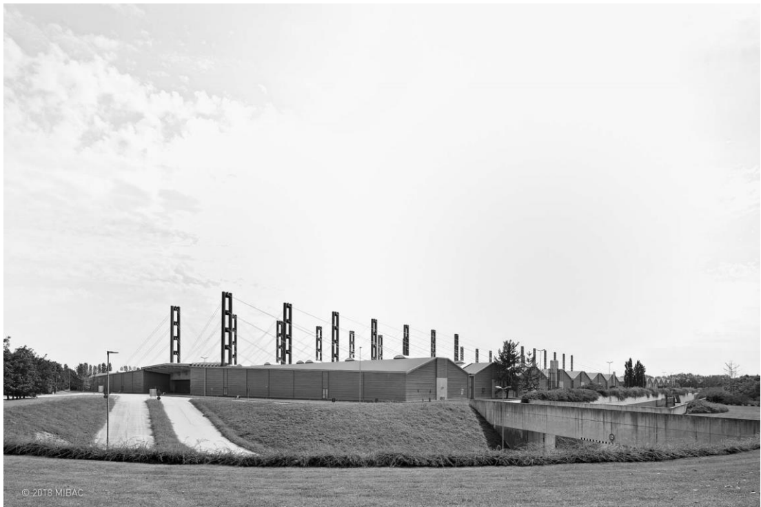
Fig. 6 - Afra e Tobia Scarpa, Magazzino robotizzato, Castrette di Villorba, 1980 (Benetton Group).
