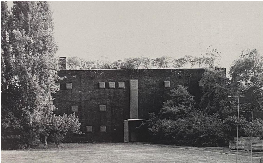
Fig. 9 - Afra e Tobia Scarpa, Casa di Trevignano (facciata nord), 1969.
