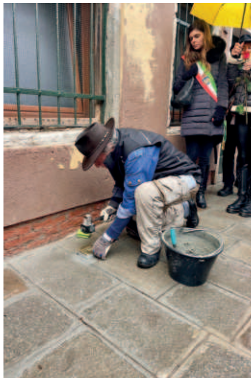
Foto 2.1: Gunter Deming all'ultima cerimonia di posa delle pietre d'inciampo a Venezia (17 gennaio 2023).
