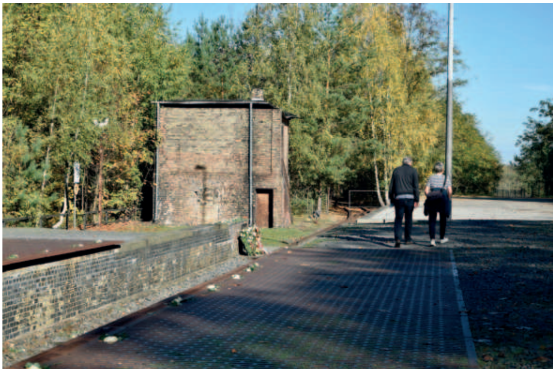
Foto 1.18: Veduta del binario in direzione est.
