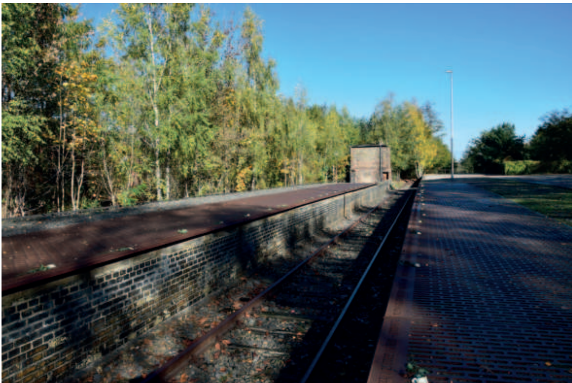
Foto 1.16: Binario della stazione di Grunewald, oggi diventato monumento a ricordo delle vittime da qui deportate.
