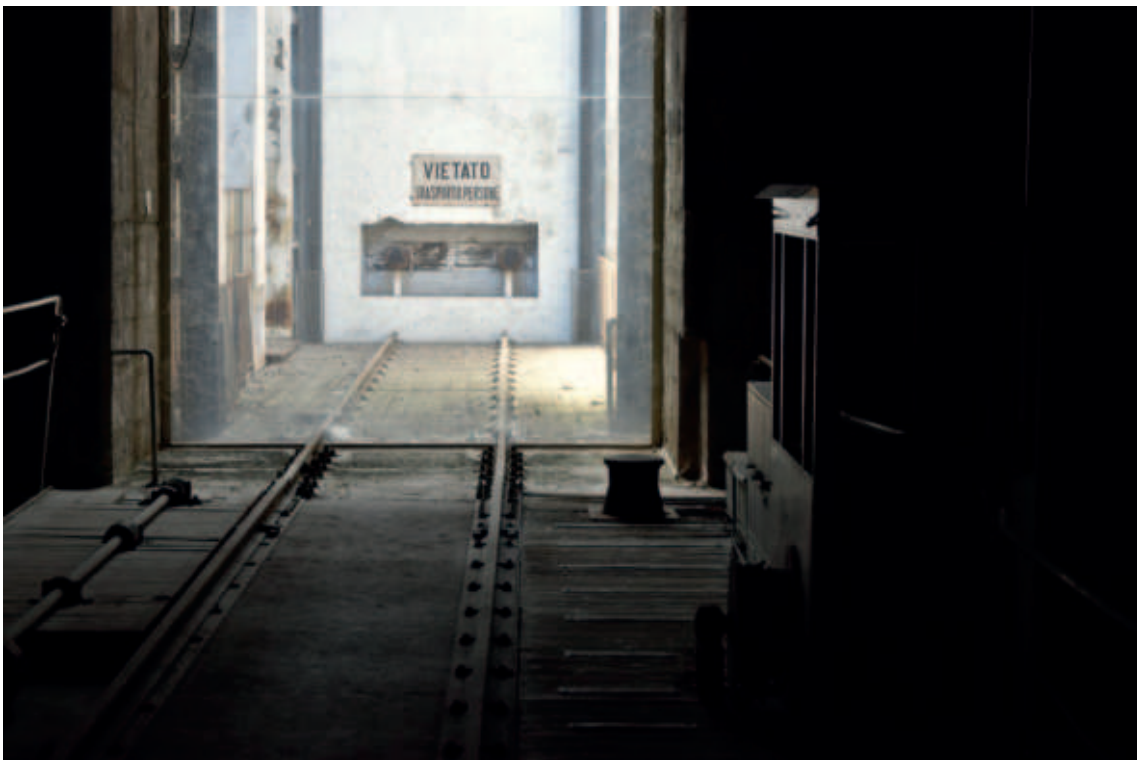
Foto 1.10: Fossa di traslazione per issare al piano superiore i vagoni con la relativa cabina di manovra.
