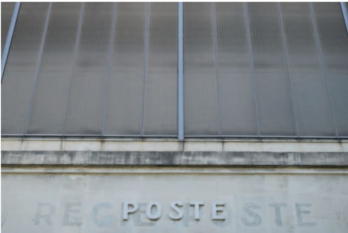
Foto 1.2: Palazzo delle Regie Poste su via Ferrante Aporti.
