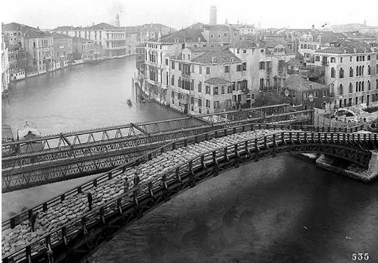
Figura 17: Collaudo statico del nuovo Ponte in legno dell'Accademia, 1933
