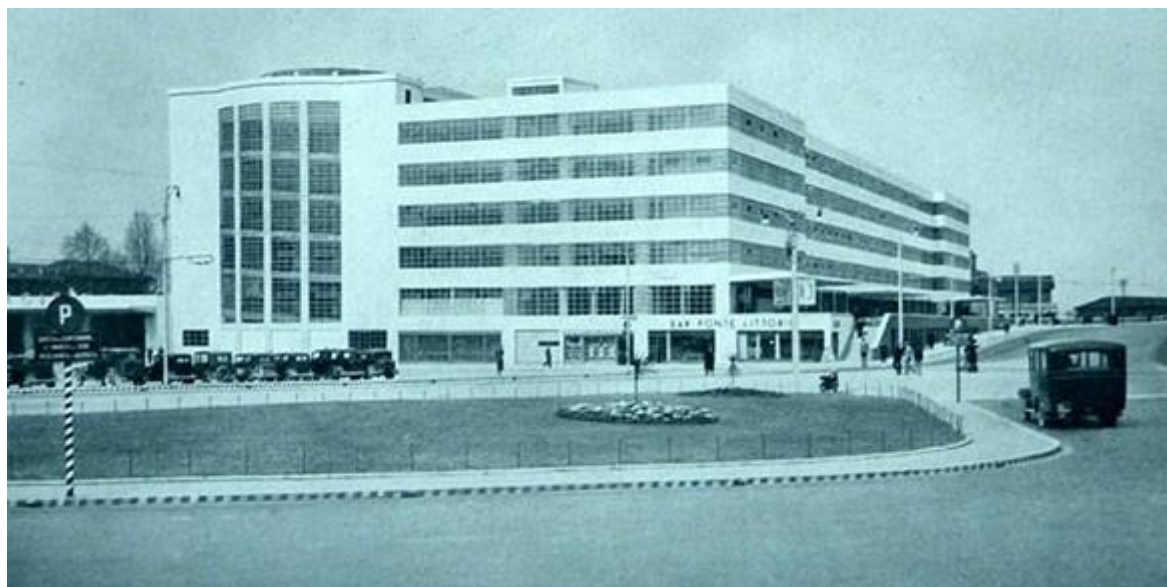
Figura 14: L'Autorimessa Sant'Andrea vista da piazzale Roma, 1934
