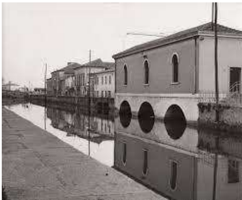
Figura 37: Il manufatto idraulico dell'Arco di Mezzo a Battaglia Terme. Fonte: Salmaso T., Museo Civico della Navigazione Fluviale di Battaglia Terme
