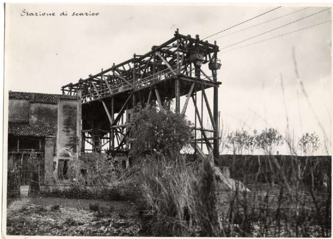
Figura 67: Stazione di scarico della teleferica Bonetti in prossimità del Porto di Mezzavia, in località Due Carrare. Fonte: Museo Civico della Navigazione Fluviale di Battaglia Terme
