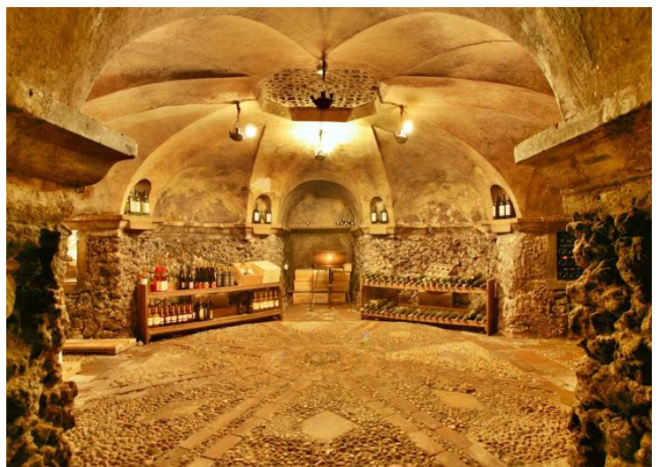
Figura 9 La cantina dell'attuale ristorante Villa Eolia (Vicenza). La griglia situata al centro della stanza è il punto di incontro del "sistema di ventidotti". Fonte: www.vicenzatoday.it
