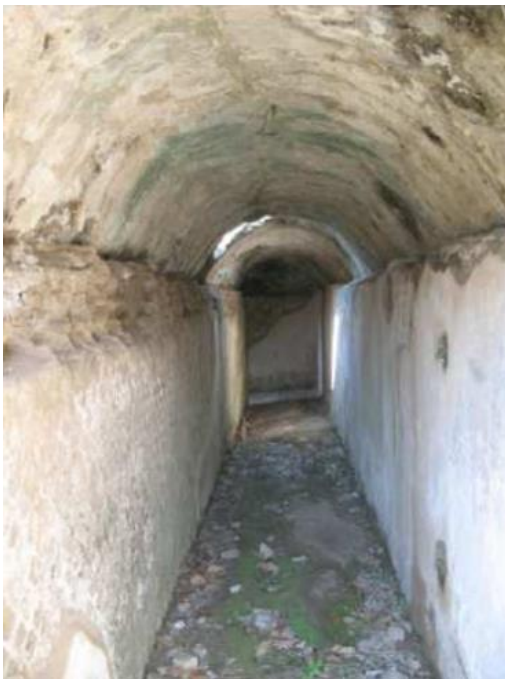
Figura 8 Corridoio di ventilazione seminterrato, villa Adriana (Roma). Fonte: Di Ruocco, G, 2018.
