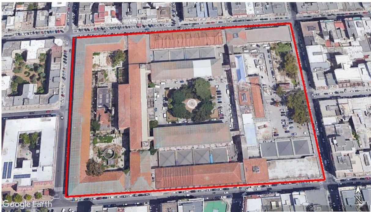
Figura 14 Immagine aerea dell'Ex Manifattura Tabacchi di Bari, nel riquadro rosso. Fonte: Google Earth.
