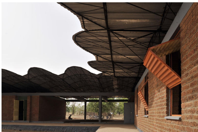
Figura 14. Scuola secondaria a Dano in Burkina Faso. Cortile interno dove è possibile vedere il tetto costruito con materiali locali. Le persiane invece, sono tutte scorrevoli e suggeriscono un elemento di grande design all'edificio. Immagine presa dal sito: https://www.laterizio.it/cil/progetti/374-high-school-building-a-dano-burkina-faso.html
