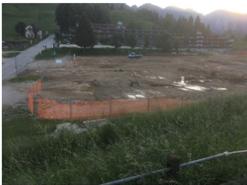
Figura A.37: cantiere per la costruzione del nuovo parcheggio a pagamento di Recoaro Mille, 07/06/2022
