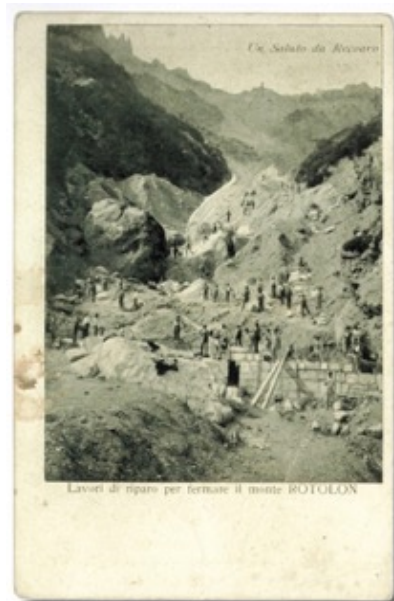
Figura A.19: il rischio idrologico è sempre stato presente e mai completamente risolto. Qui si vedono opere atte a ridurre la pericolosità del Monte Rotolon, che già dal nome fa intuire la sua natura instabile
