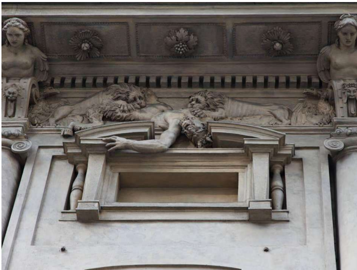
Fig. 12 – Casa degli Omenoni, rilievo con satiro dilaniato da due leoni
