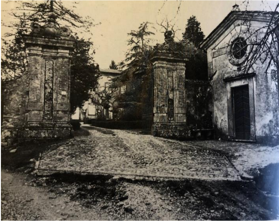
Figura 24, ingresso di Villa Controni a Vorno.
