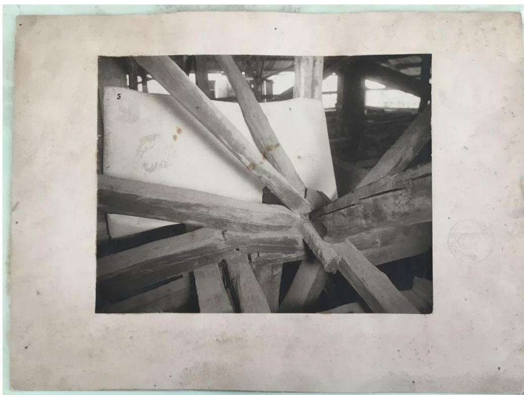
Fig. 19. Fotografia della carpenteria lignea del soffitto della Loggia (A. Garatti, *post* 1911).
