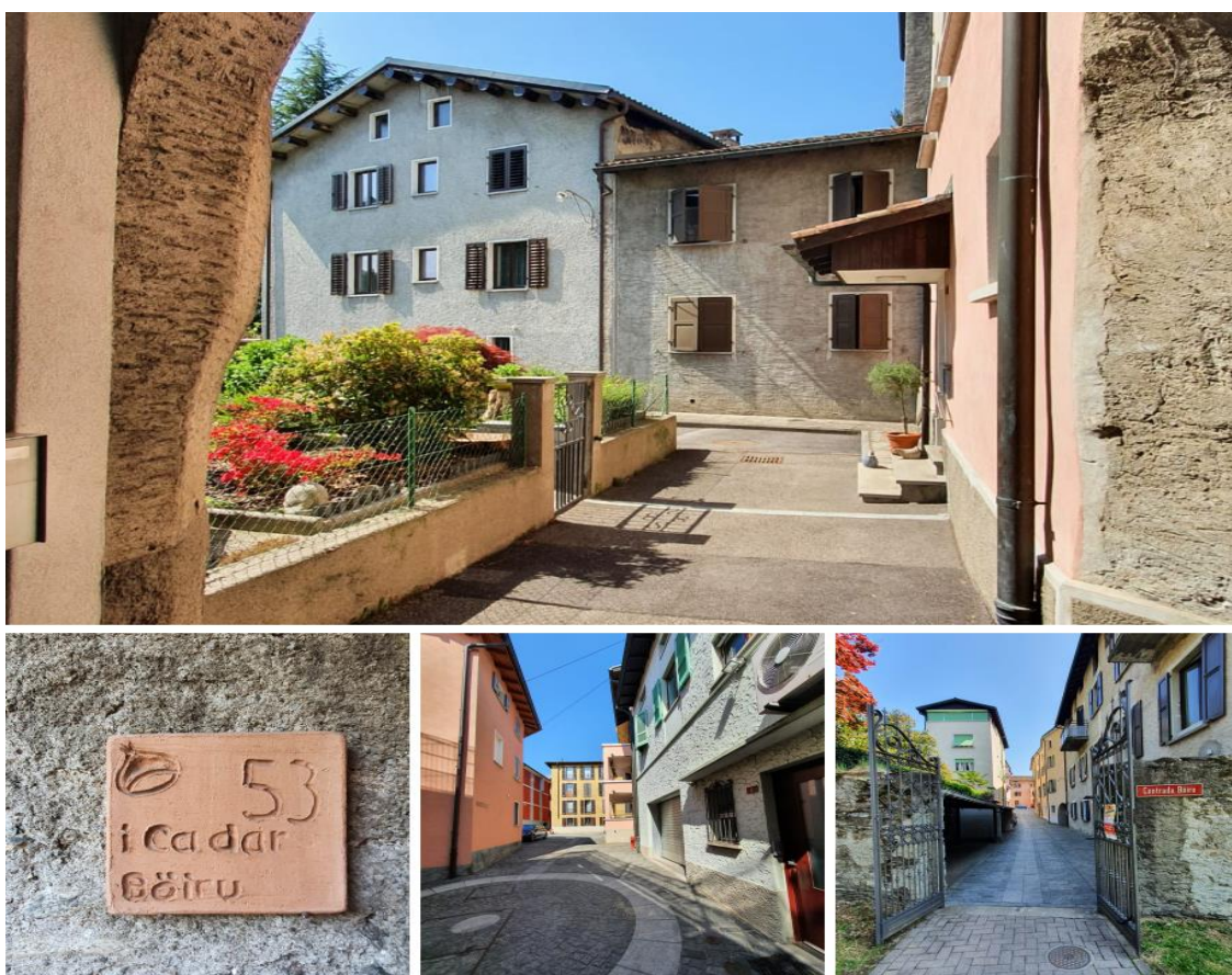
Fig.38. Il nucleo storico di Bioggio, con gli edifici della tradizione, a confine con il parco pubblico. Fonte: fotografie personali del 28.04.2022.
