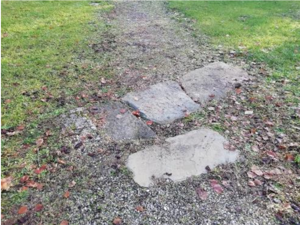
Fig. 6 Dettaglio resti ponte sul canale di troppo pieno, 2021
