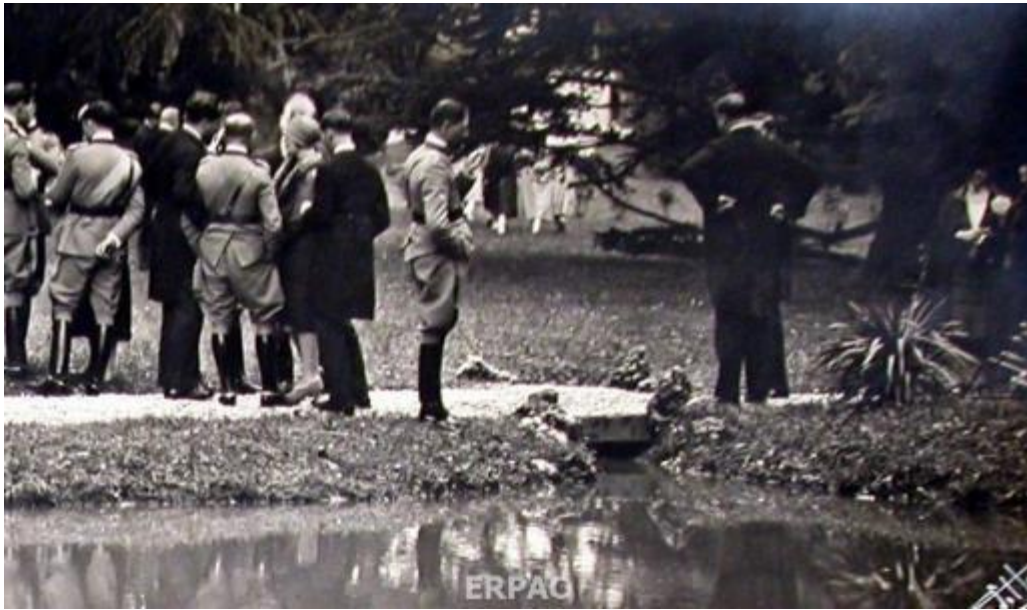
Fig. 4 Dettaglio ponte e canale di troppo pieno, 1926 (Archivio fotografico ERPAC – Servizio catalogazione, promozione, valorizzazione e sviluppo del territorio)
