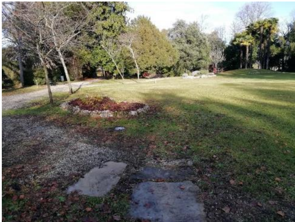
Fig. 7 Dettaglio resti ponte sul canale di troppo pieno
