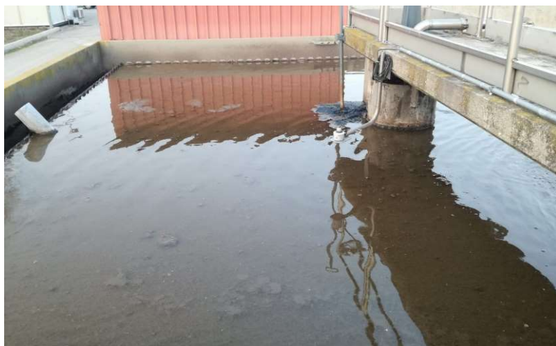
Figura 6: L'ispessitore statico a gravità del WWTP di Treviso.
