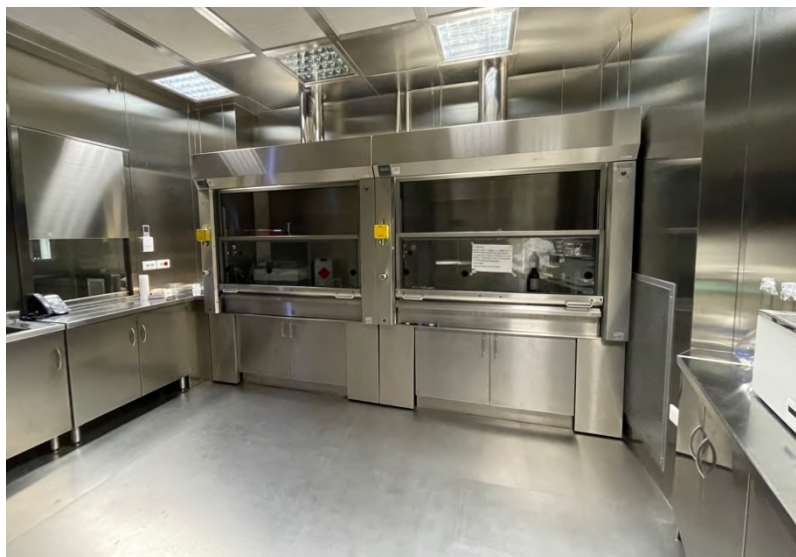
Figura 2.4 Cleanroom ISO 7 adibita all'analisi di composti organici.
