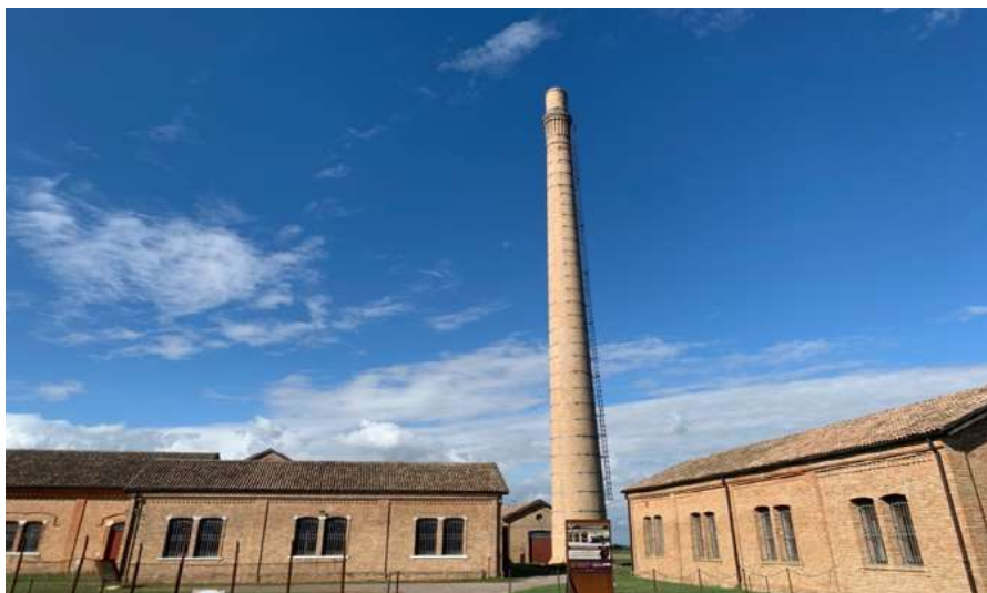
Figura 6 Camino e edifici Idrovora di Ca'Vedramin, Taglio di Po Fonte: realizzata dall'autrice
