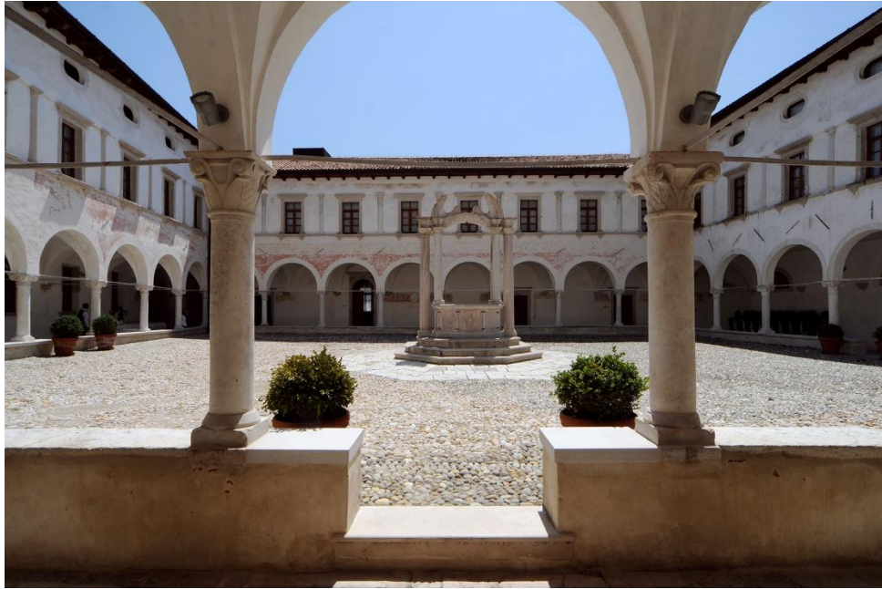
Figura 20 Ex Convento di San Francesco (Conegliano)
