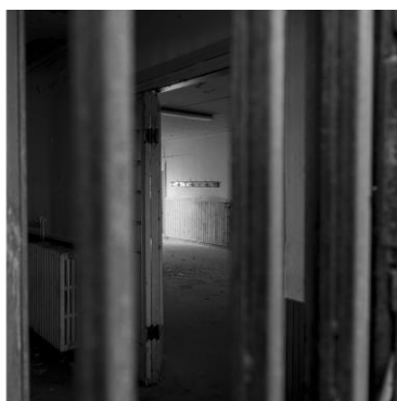
Ex Casa del Fascio e dell'Ospitalità, Predappio, dettaglio interni ©Alice Naso
