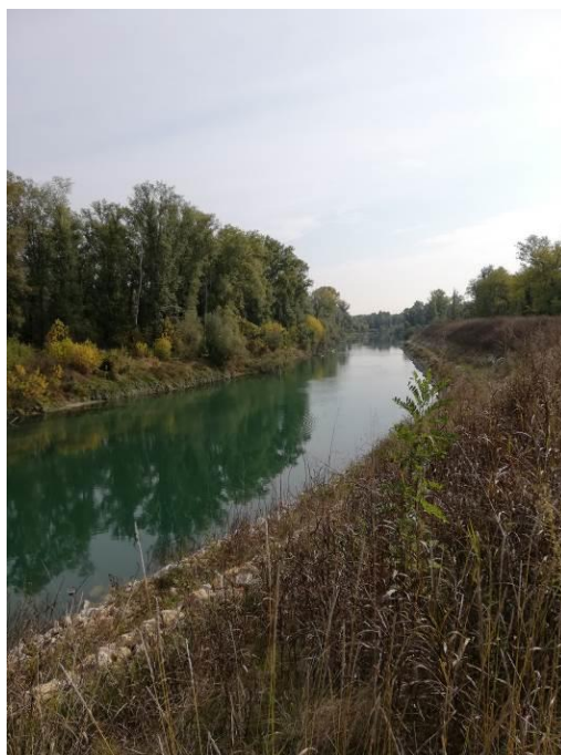
Figura 31 Argine fiume Brenta presso Carturo
