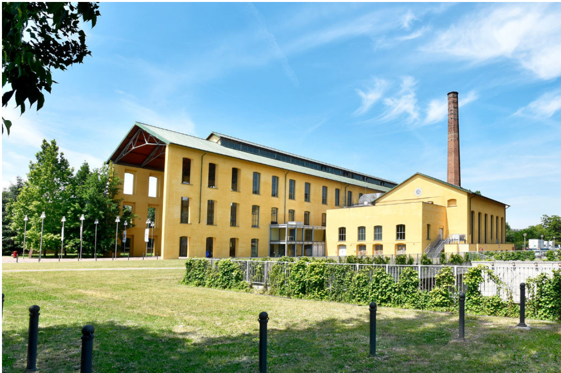
Figura 3.6 L'esterno dello stabilimento dopo l'intervento di recupero, anni '00
