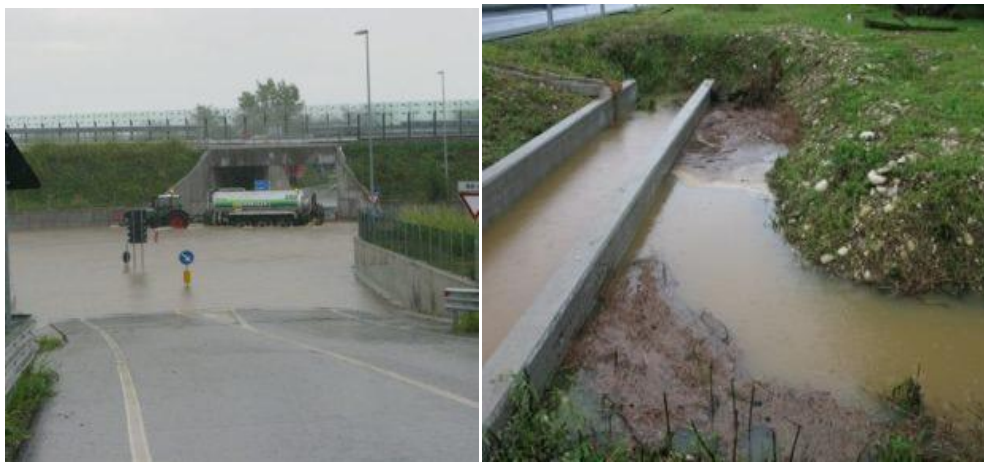
Fig. 4 - Allagamenti, “Spv: ancora allagamenti. Tutto preannunciato” (AltoVicentinoOnLine, 31/08/2020) - https://www.altovicentinonline.it/attualita-2/spv-ancora-allagamenti-tutti-preannunciato/?fbclid=IwAR2EJDo117ewyX5GF8-2fdOpgCXIfFNMIsc05ccvYQIzyiDYFt_EQHBKXok .
