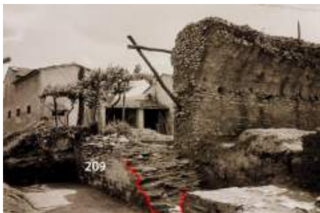
Fig. 110 Le strutture del Grande Tempio ancora utilizzate per attività agricole all'epoca delle indagini di Inglieri. In primo piano è evidenziata in rosso l'asportazione di una porzione di USM 209, oggi risarcita (Archivio "A. Frova").
