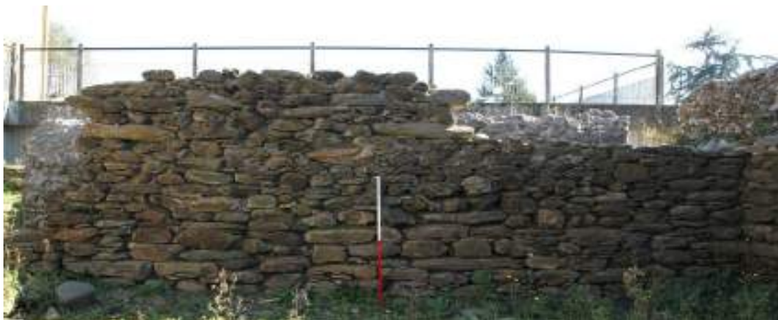
Fig. 53 USM 200 come appare oggi, vista da nord-ovest.
