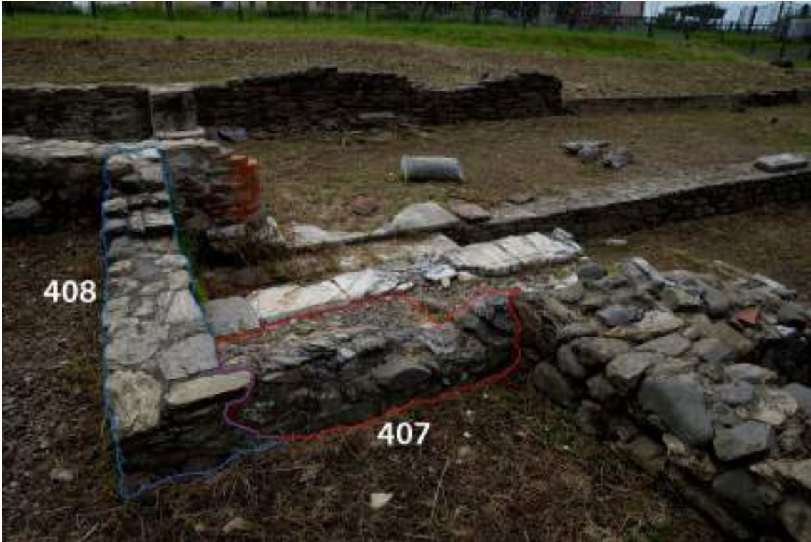
Fig. 81 USM 407 e 408 come appaiono oggi, viste da nord.
