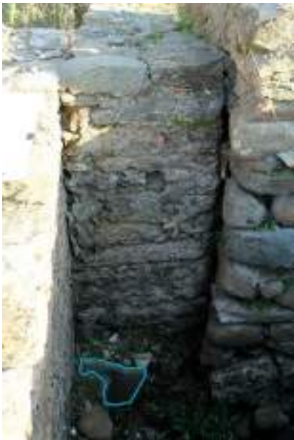
Fig. 71 Particolare di USM 302 con una porzione di lastra in bardiglio messa in opera sul suo fianco ovest.
