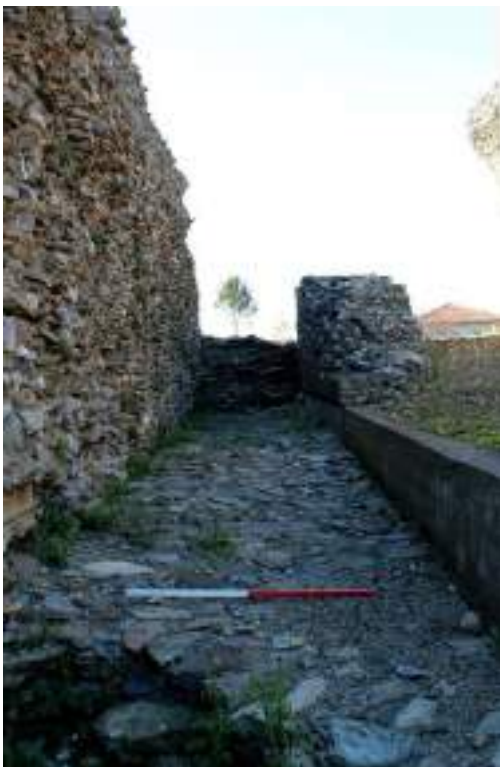
Fig. 60 USM 207 come appare oggi, vista da sud-est.
