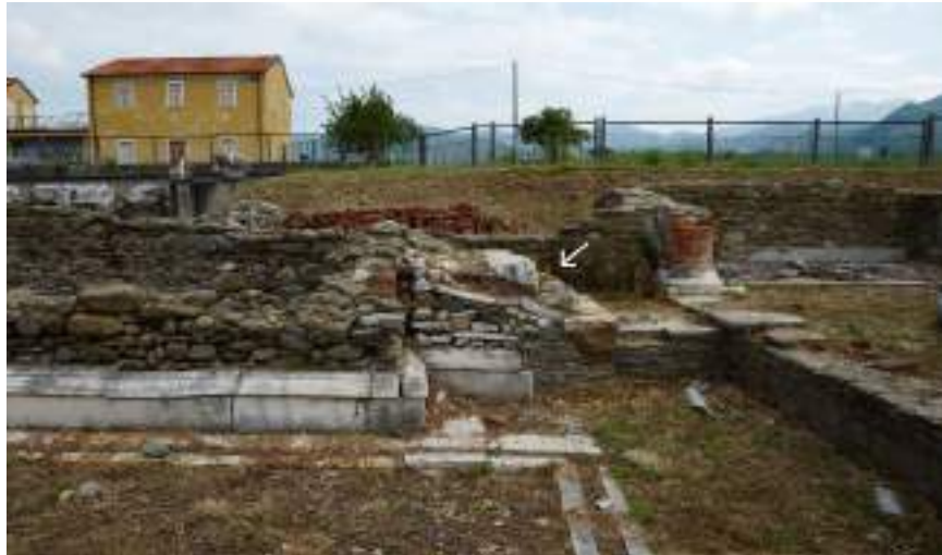
Fig. 143 La scalinata laterale che collega il portico SE e la passerella verso il tempio.
