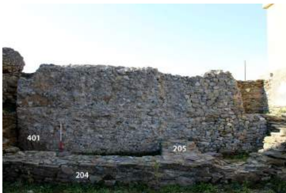
Fig. 86 USM 401 come appare oggi, vista da sud-est.
