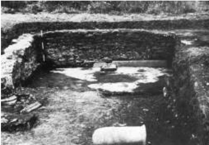
Fig. 144 La base in conglomerato al momento della scoperta (da BONGHI JOVINO 1977a, tav.220,6).
