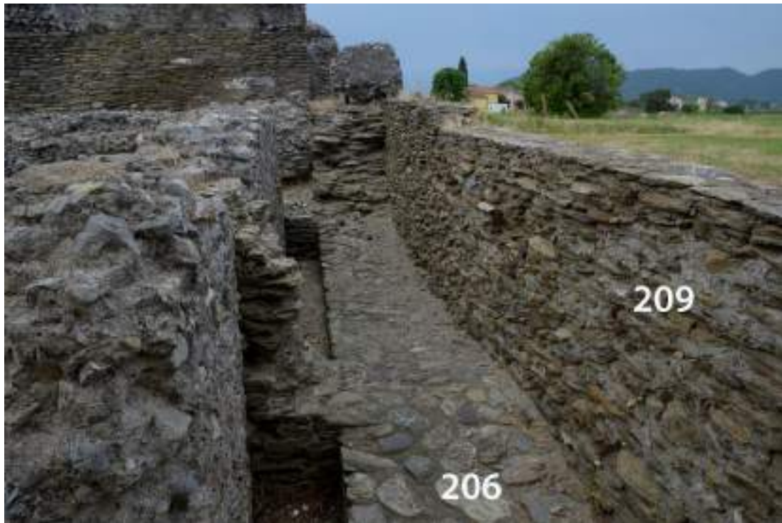
Fig. 59 USM 206 come appare oggi, vista da nord-est.
