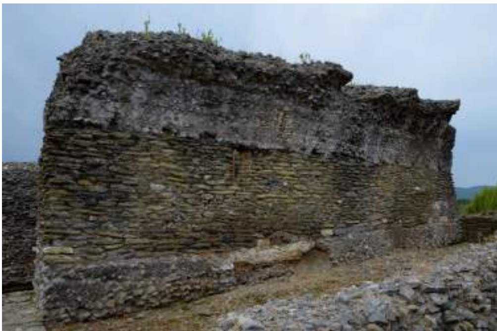
Fig. 90 USM 403 come appare oggi, vista da est.
