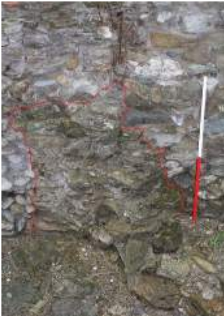
Fig. 63 USM 212 come appare oggi, vista da nord-est.
