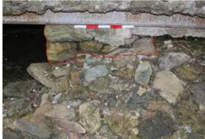
Fig. 64 USM 213 come appare oggi, vista da nord-est.
