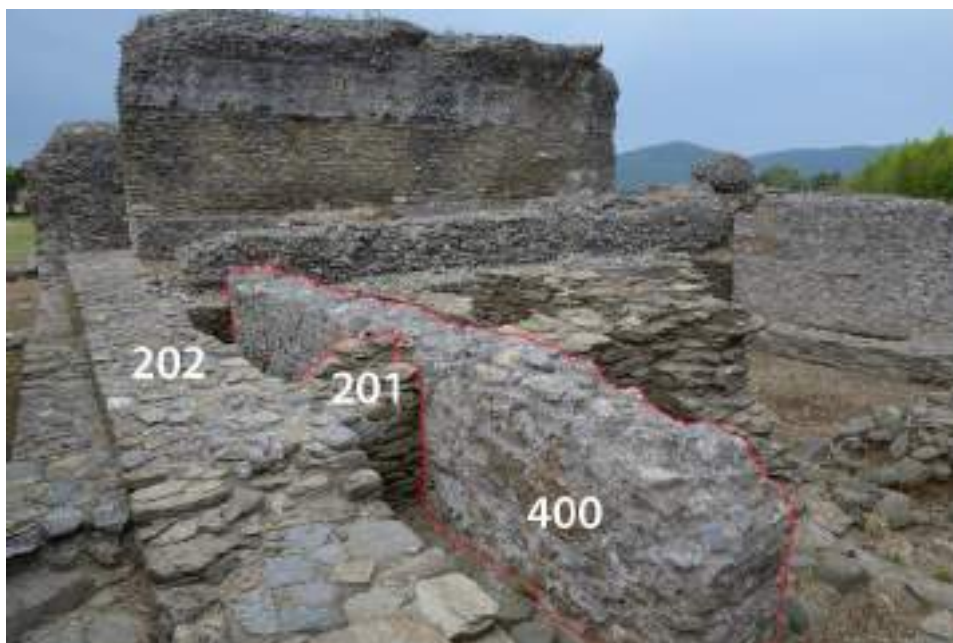
Fig. 85 USM 400 come appare oggi, vista da est.
