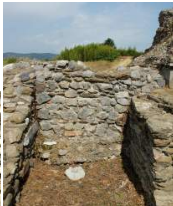
Fig. 80 USM 409 come appare oggi, vista da sud-est.
