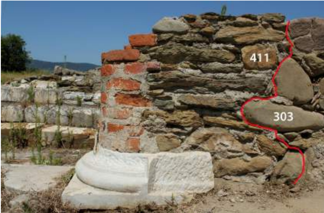
Fig. 83 USM 411 come appare oggi, vista da sud-est.
