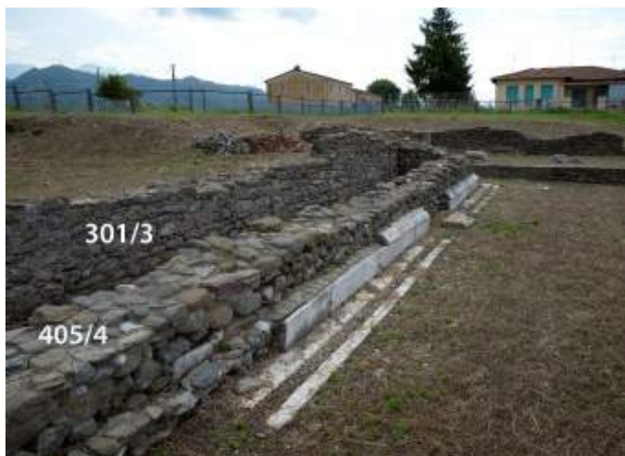
Fig. 77 USM 405/4 come appare oggi, vista da ovest, e la canaletta di scolo che corre tutta intorno alla piazza.
