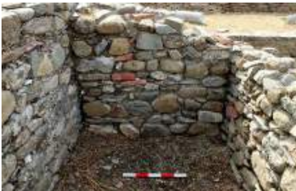
Fig. 79 USM 406 come appare oggi, vista da nord-ovest.
