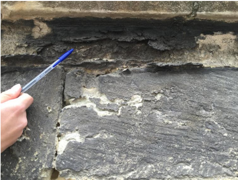
Figura 4: un sottile strato di croste nere formato su una pietra carbonatica facente parte di muro di una chiesa nella città di Fécamp (Francia). Da (Genot, et al., 2020) (modificato).
