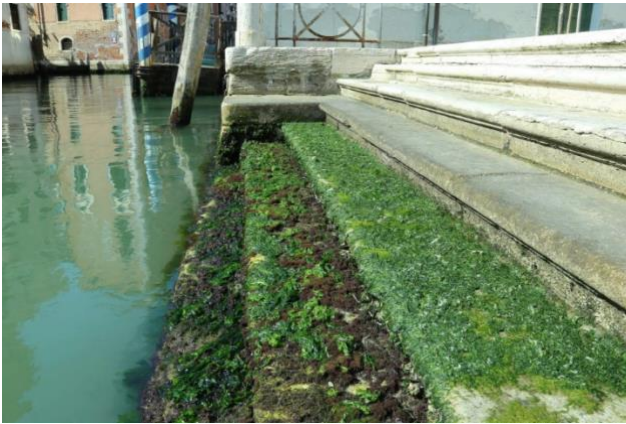
Figura 5: alghe cresciute a ridosso degli edifici a Venezia. Nella città lagunare il fenomeno è molto comune, sostenuto dalle maree e dal moto ondoso dovuto all'intenso traffico marittimo. Da https://www.domusweb.it/en/design/gallery/2020/04/07/the-polluting-algae-in-the-venetian-lagoon-become-stamps.html (modificato).
