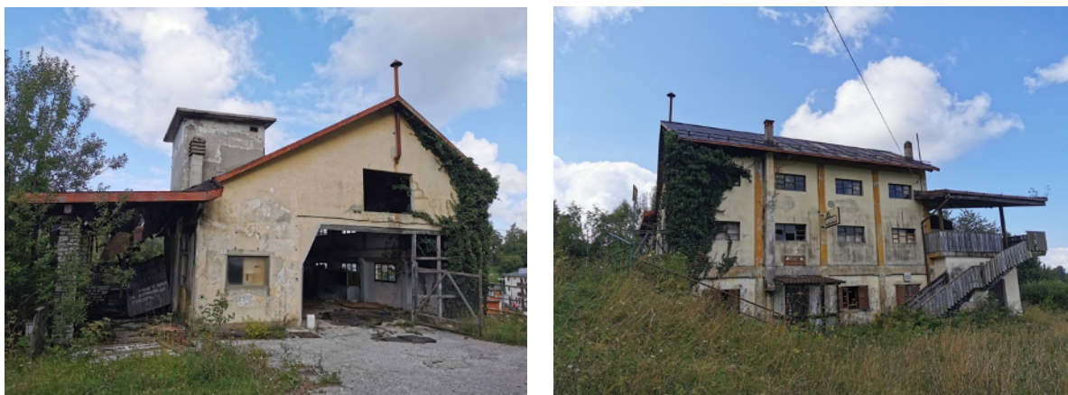
Figura 34. Partenza della vecchia seggiovia: edificio pericolante molto vicino al piazzale. Foto mie.
