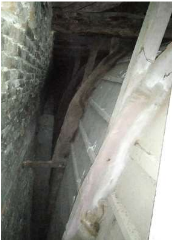
Figura 110 – Controsoffitto della chiesa di San Pantalon con i sostegni ai quali sono ancorate le patere che sostengono i teleri dipinti dal Fumiani, su di una colonna verticale che sostiene le capriate del tetto è stata scritta la data di fine lavori di restauro del 1886.
