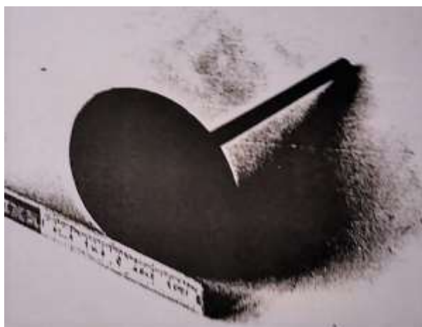
Figura 109 - Le patere che servivano ad ancorare i telai dei dipinti alla travatura del controsoffitto nelle uniche immagini disponibili, si nota che erano lunghe circa 50 cm ed avevano un diametro di circa 15 cm.
