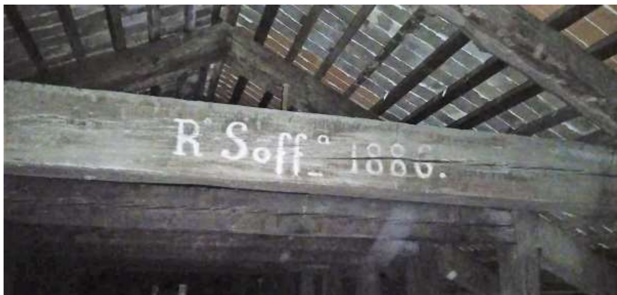
Figura 116 - La testimonianza del restauro al soffitto fatto dalla ditta Vincenzo Biondetti nel 1886 in una scritta in vernice bianca su una delle centine delle capriate che sostengono il tetto della chiesa.
