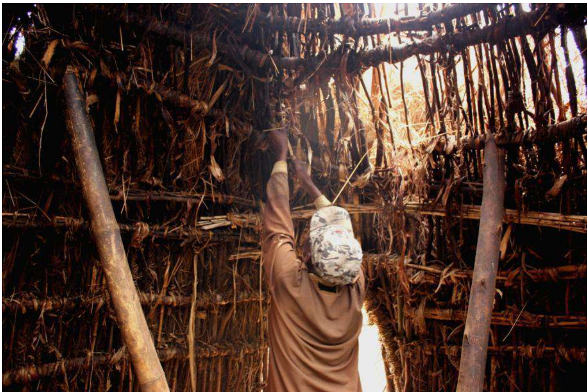
Figura 34. Uno dei costruttori riceve e passa all'esterno l'ago di bambù con la corda per fissare la paglia che ricopre l'abitazione, Mudaka
