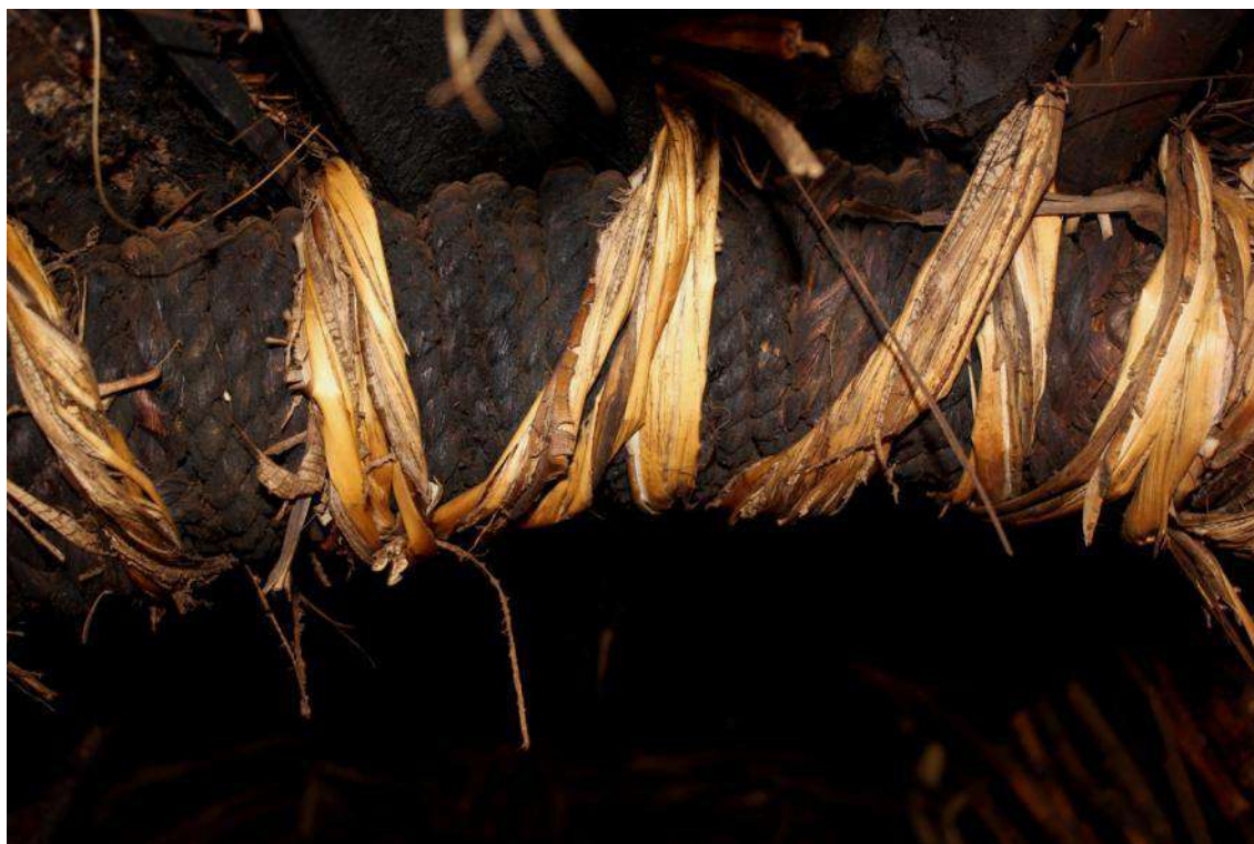
Figura 47. Esempio di corde in fibra di banano utilizzate per la costruzione di una casa, Cirunga
