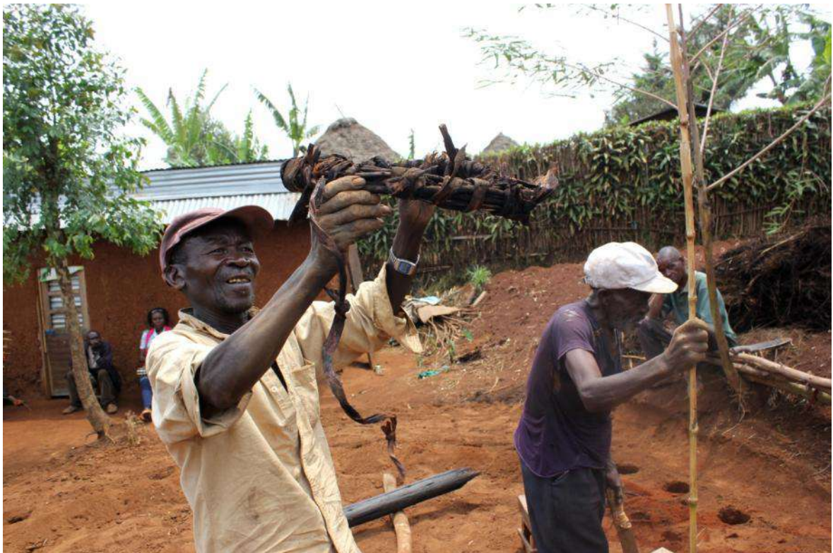
Figura 28. L'ultimo anello in canne intrecciate da porre in cima al tetto della bandamusongya , Lurhala
