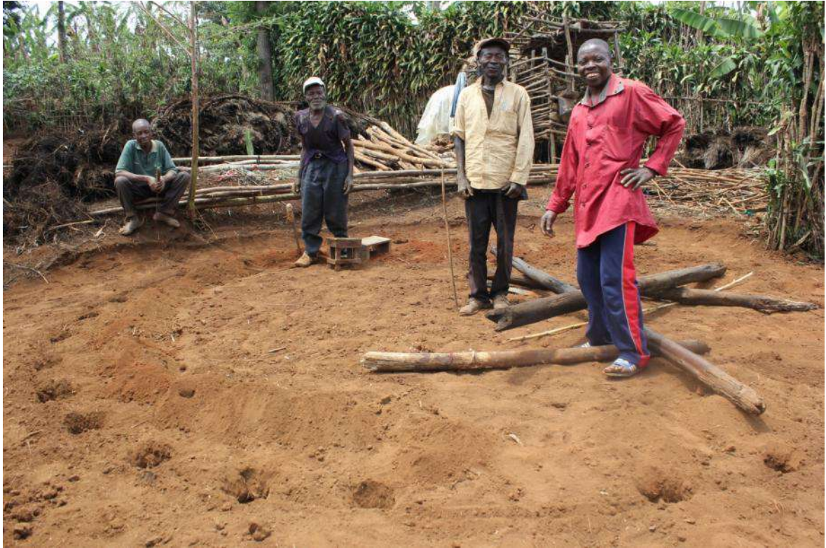
Figura 25. Un gruppo di costruttori dopo aver scavato i buchi per i pali della circonferenza di una futura bandamusongya , Lurhala
