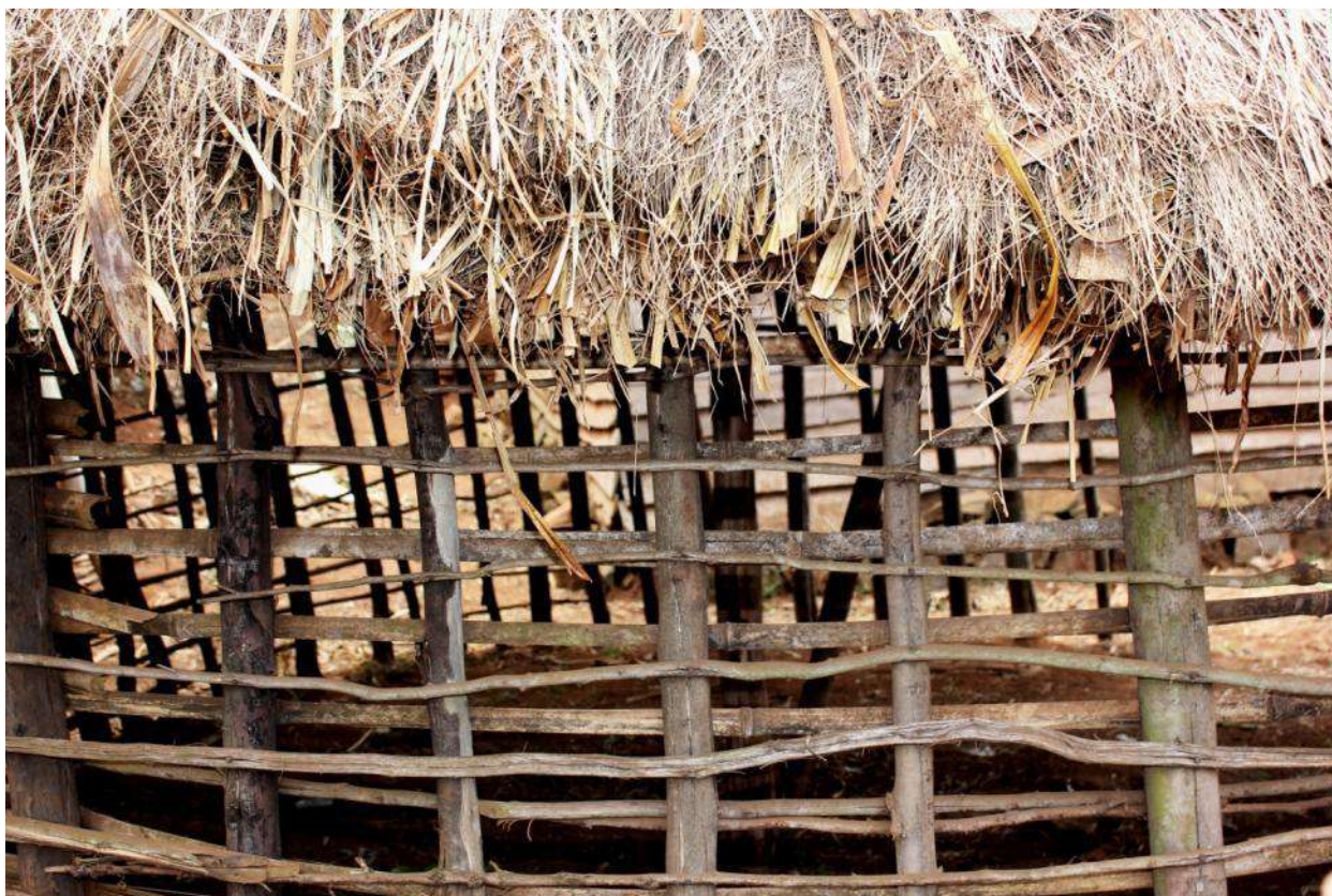
Figura 30. Intelaiatura e tetto di una bandamusongya prima dell'applicazione dei pani di terra alle pareti, Lurhala
