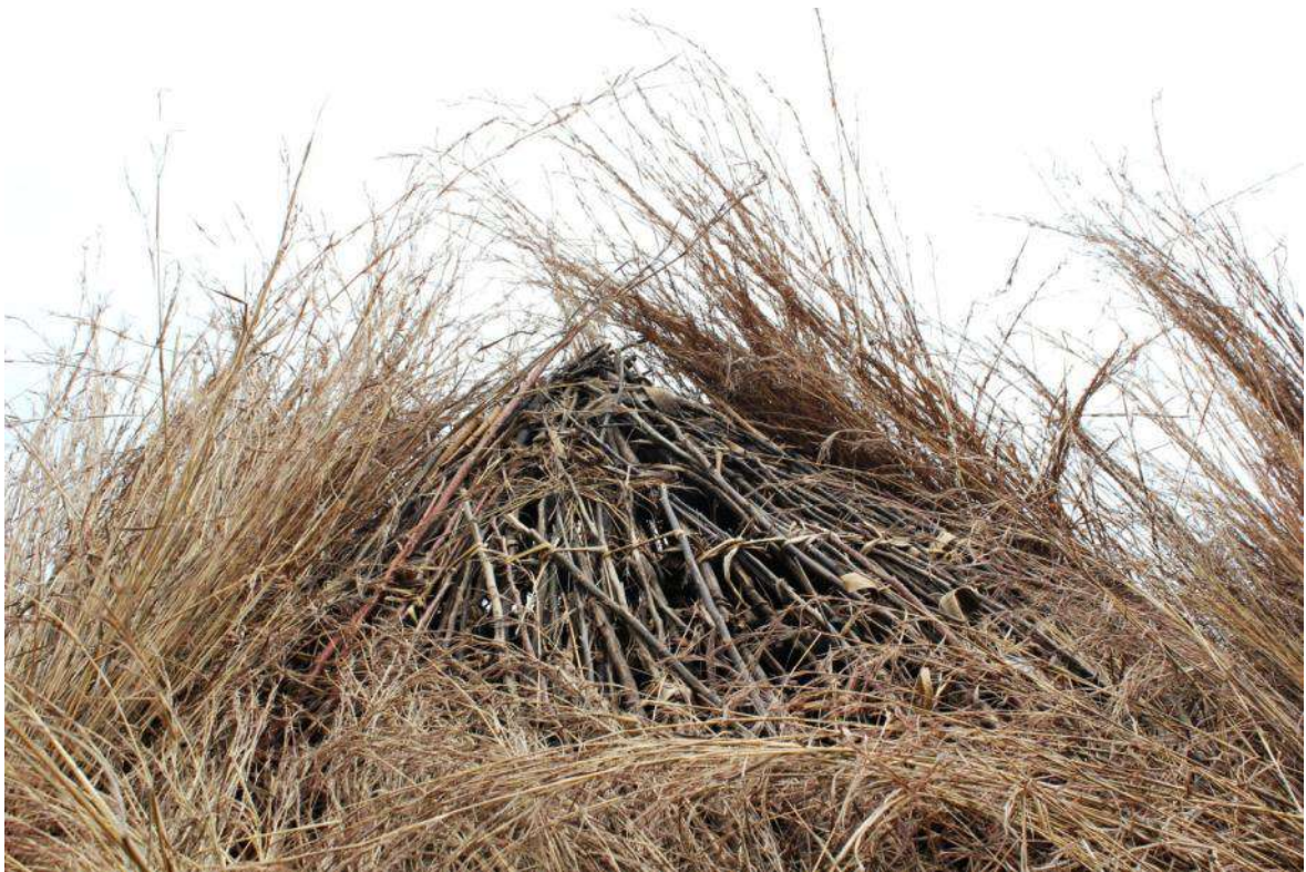
Figura 36. Parte superiore in fase di copertura, dettaglio, Mudaka
