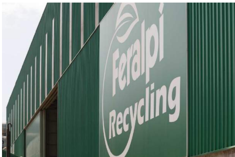
Figura 14: Impianto di riciclaggio di Feralpi
